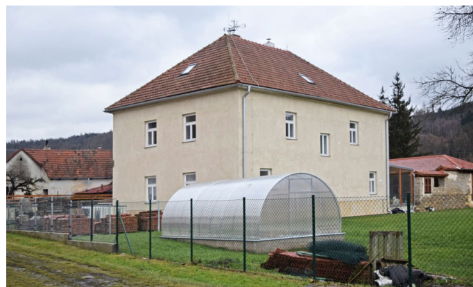
Rok 2023 - opravená budova školy
