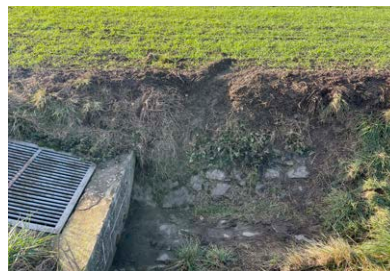
Okraj pole v podstatě neexistuje, půda postupně zanáší drenážní systém
