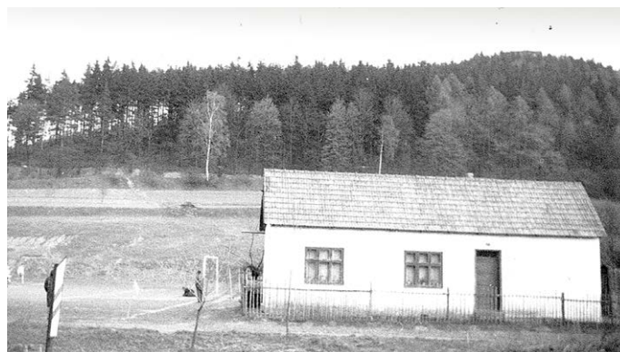
Pohled od silnice na hřiště před rekonstrukcí
