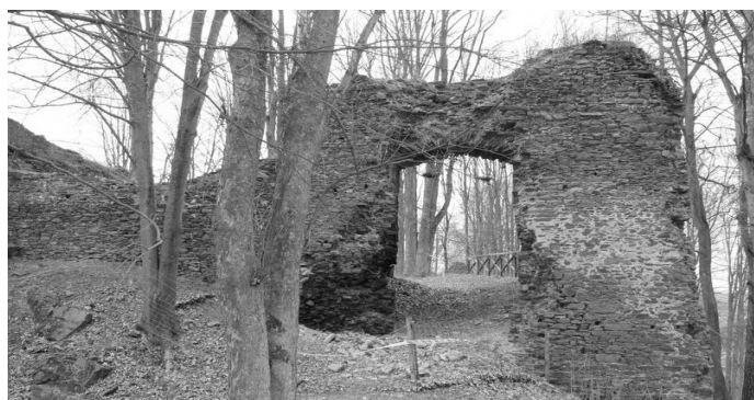
Pohled na vnější průčelí vstupní brány do předhradí od jihovýchodu
