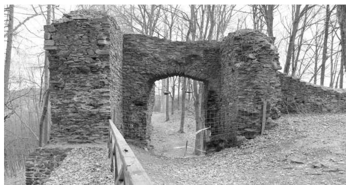
Celkový pohled na obě čela bočních stěn a vnitřní líc vstupní brány do předhradí
